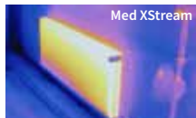
Radiator uden luft eller smuds
