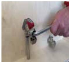
Auch an schwer zugänglichen Stellen montieren: Beschädigungsfreie Montage mit durchgestecktem Inbusschlüssel!
