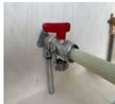
¡El eurocono en el lado de salida permite conectar todas las tuberías con adaptadores de compresión!
